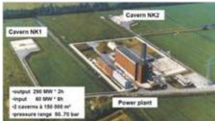
Elektrownia Huntorf - widok z lotu ptaka
